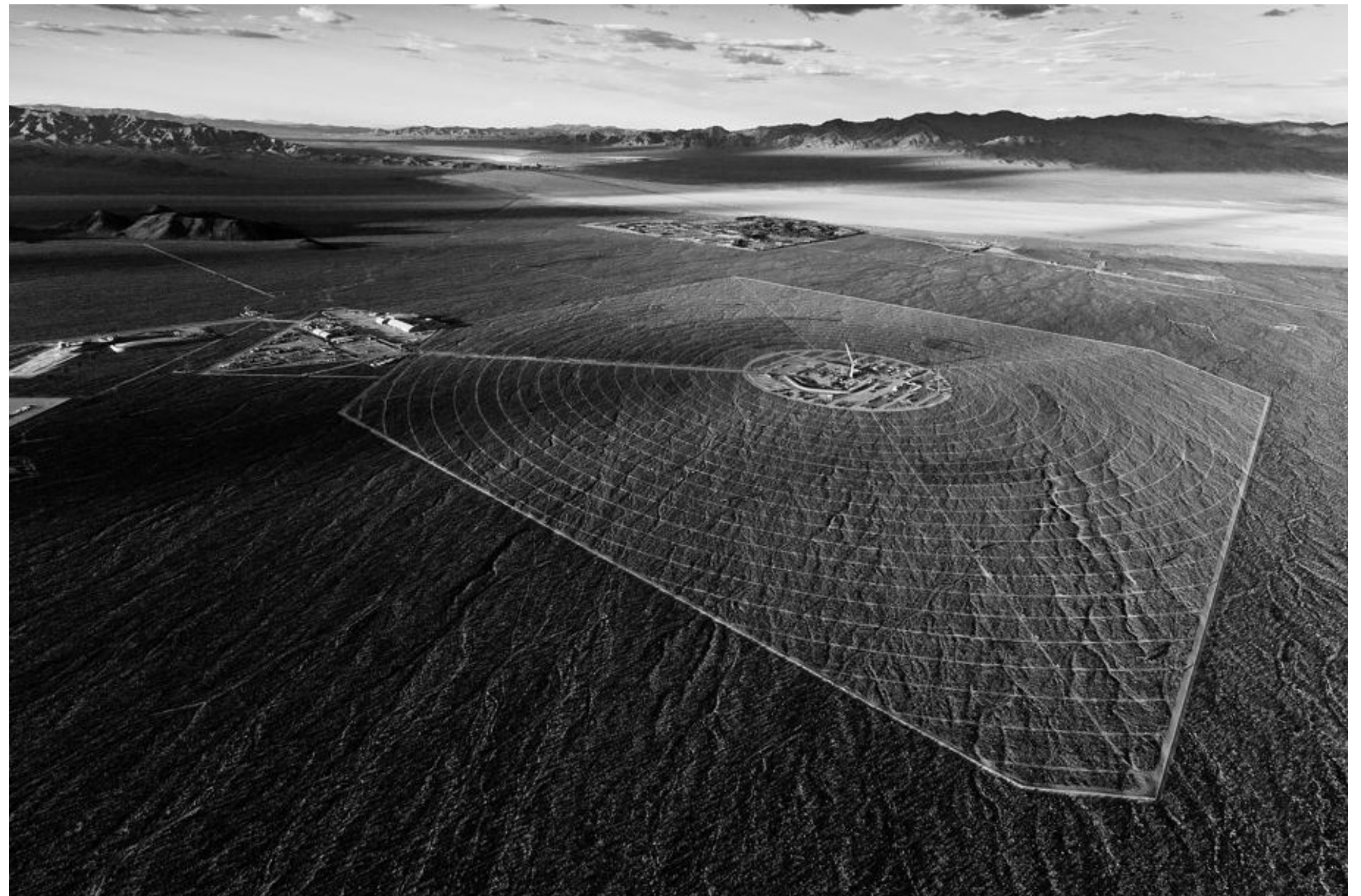
Ivanpah Solar Electric Generating System est un projet de centrale solaire thermique d'une capacité de 370 mégawatts en cours de construction dans le désert de Mojave, en Californie. La fin du chantier est prévue courant 2013 et pourrait servir de modèle pour les centrales solaires du futur.
